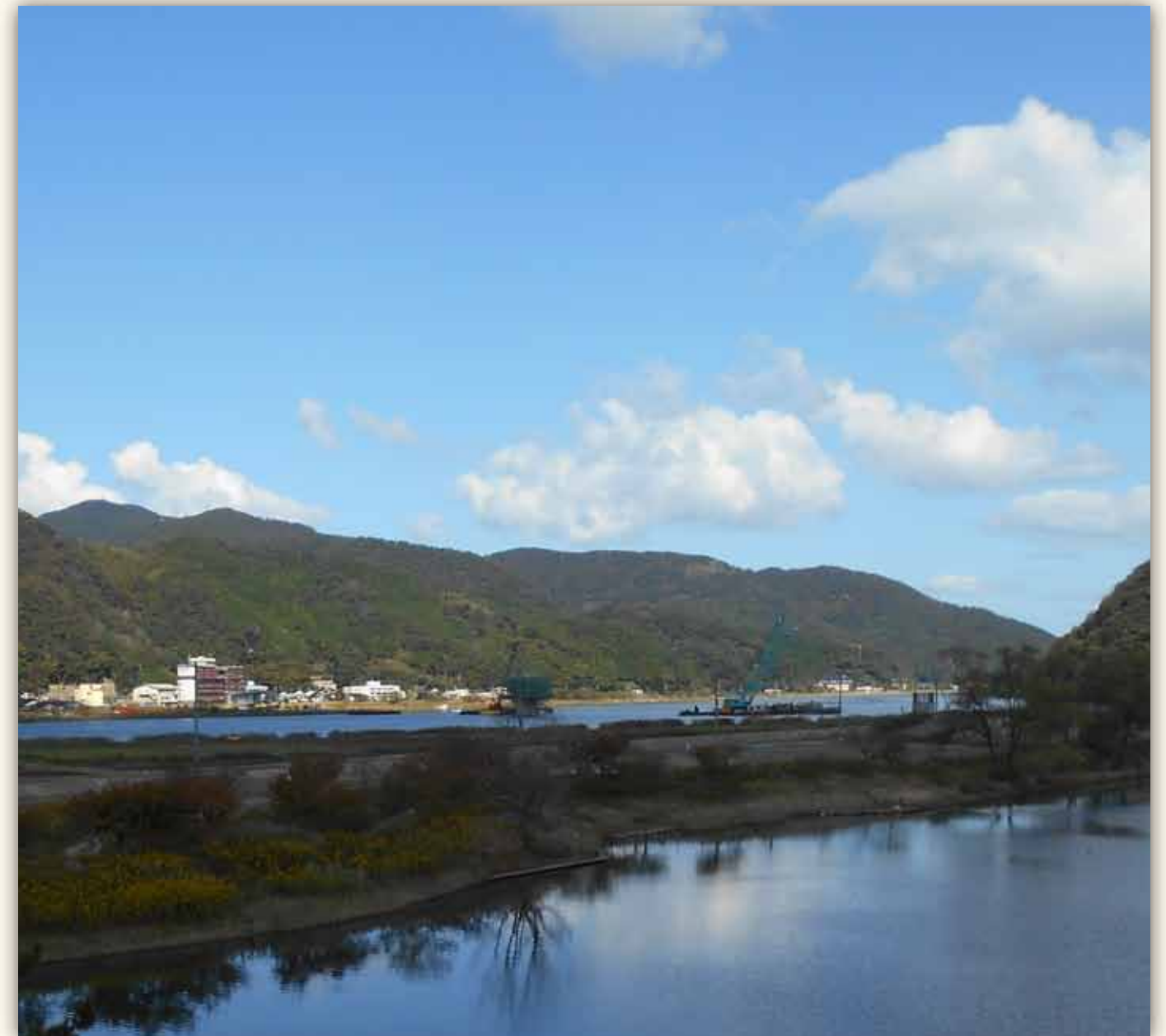
「楽々むら」から眺める 新城崎大橋架橋工事の様子(令和6年完成予定)
